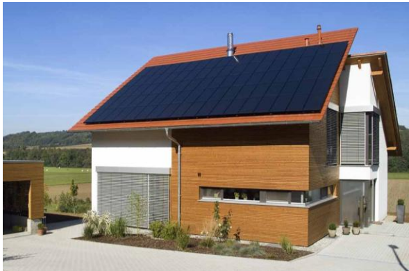
POWERline Photovoltaikanlage mit GeneCIS-Modulen von Würth Solar (Quelle: Würth Solar)
