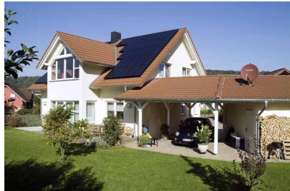
HOMEline Photovoltaikanlage mit GeneCIS-Modulen von Würth Solar (Quelle: Würth Solar)
