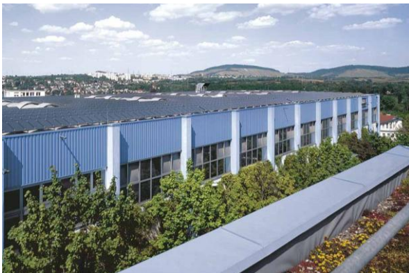
PROFline Photovoltaikanlage mit GeneCIS-Modulen von Würth Solar (Quelle: Würth Solar)
