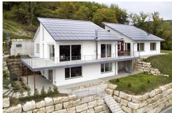
DESIGNline Photovoltaikanlage mit GeneCIS-Modulen von Würth Solar (Quelle: Würth Solar)
